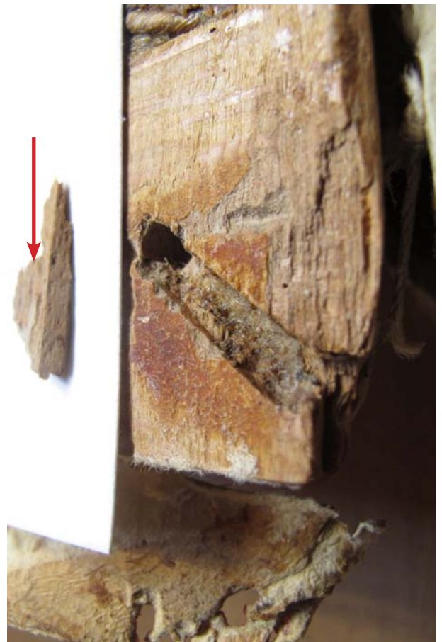
in Arbeit: Das untere Eck ist abgespalten, das Fragment ist jedoch erhalten (siehe Pfeil)
